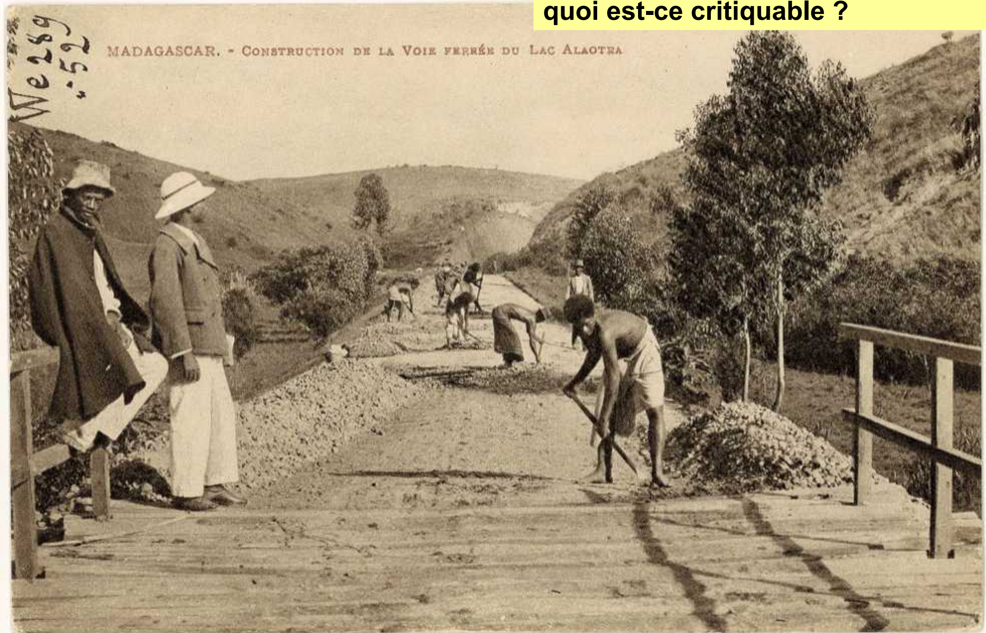
Construction de la voie ferrée Tananarive- Tamatave à Madagascar, photographie anonyme, v. 1908.
